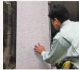
外壁は、例えば触ったら白い粉がつくような現象のチョーキングやひび割れが起きていないかを確認する
