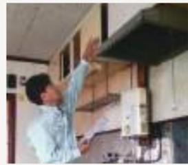
天井からの漏水の形跡がないかチェック。漏水があった場合、建物の給排水管の腐食や劣化など、設備に原因があるかも
